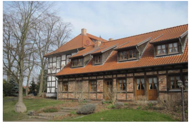
Anwesen Hauptstraße 14 (Maßnahme der DE)
